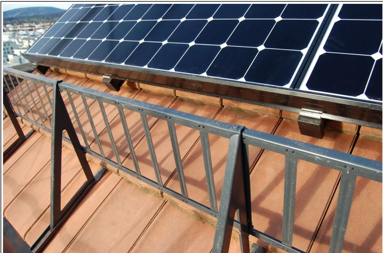
Einfache und sichere sparrenunabhängige Montage mit der Sparrenschiene.
