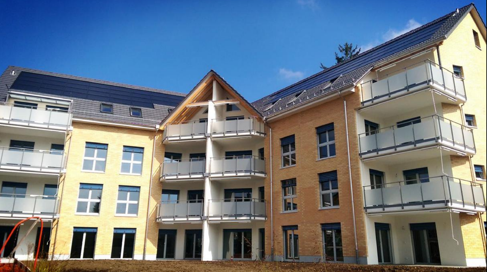
Referenzanlage von SoloSolar GmbH in Bülach
